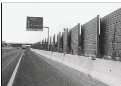
Figura 6. Pantalla discontinua en aluminio (Italia).
