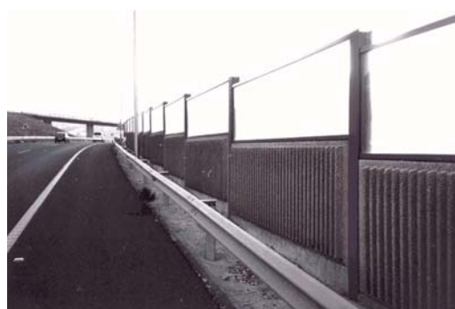
Figura 7. Pantalla con base de hormigón absorbente y elementos transparentes en la parte superior. Las Palmas de G.C. (España).
