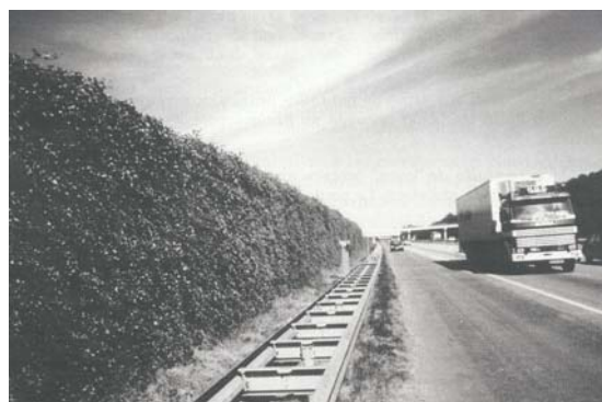
Figura 5. Pantalla con vegetación (biomuro) (Países Bajos).
