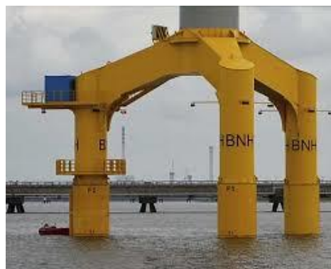
Figura 18. Cimentación por tripilotes (Fuente: [20])
